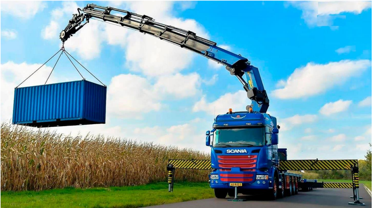
Рисунок 1.17 – Завантаження контейнера автокраном
