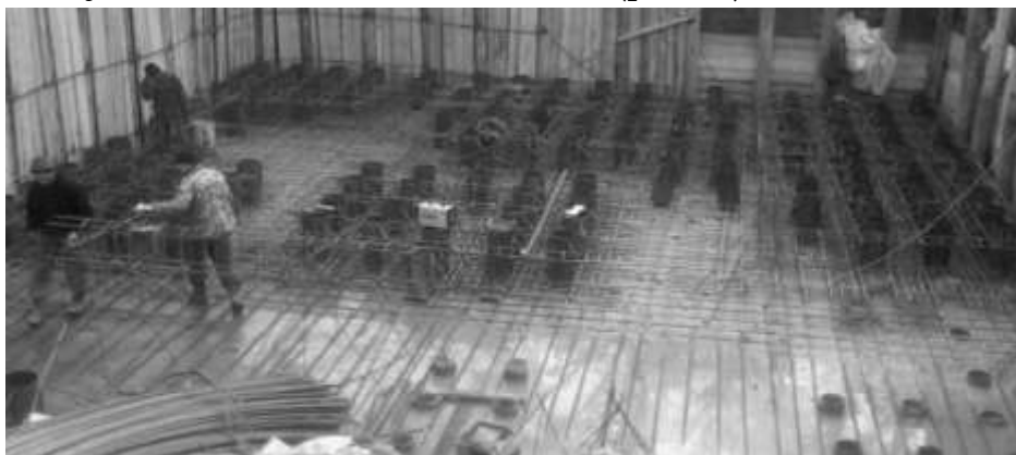
Рис. 1. Процес армування фундаментної плити та монтаж закладних деталей
