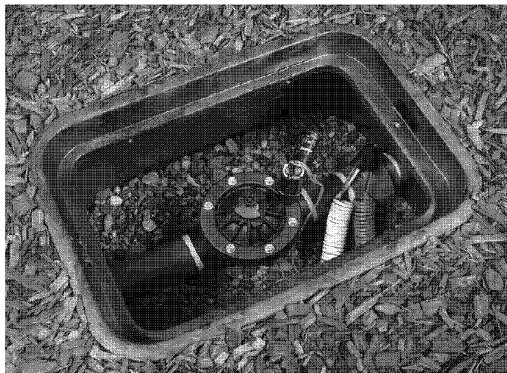
Рисунок 2.4 – Приховані електромагнітні клапани поливу
