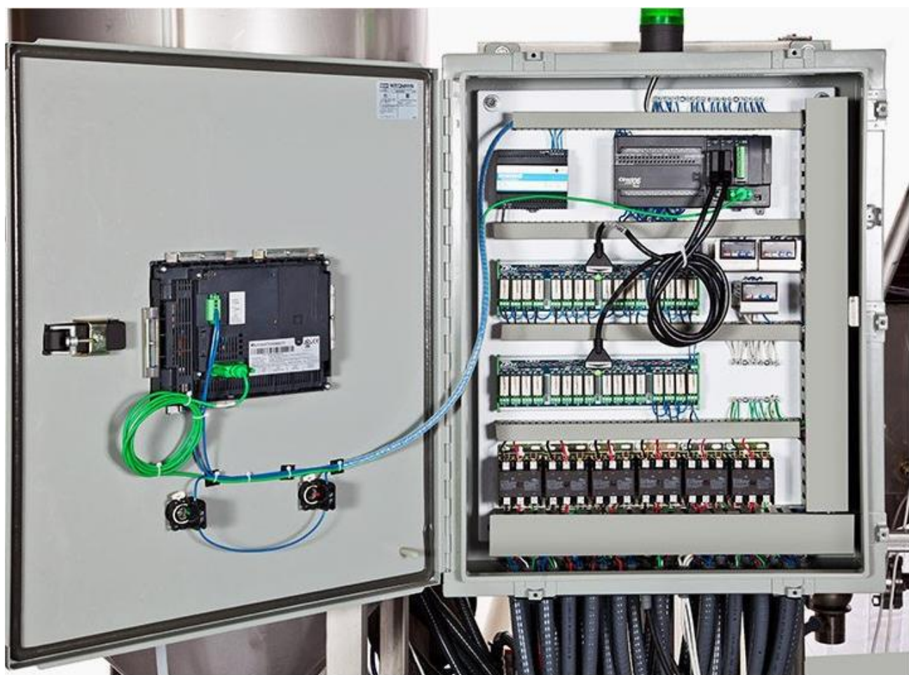
Рисунок 3.4 – Базова конструкція електричної панелі ПЛК
