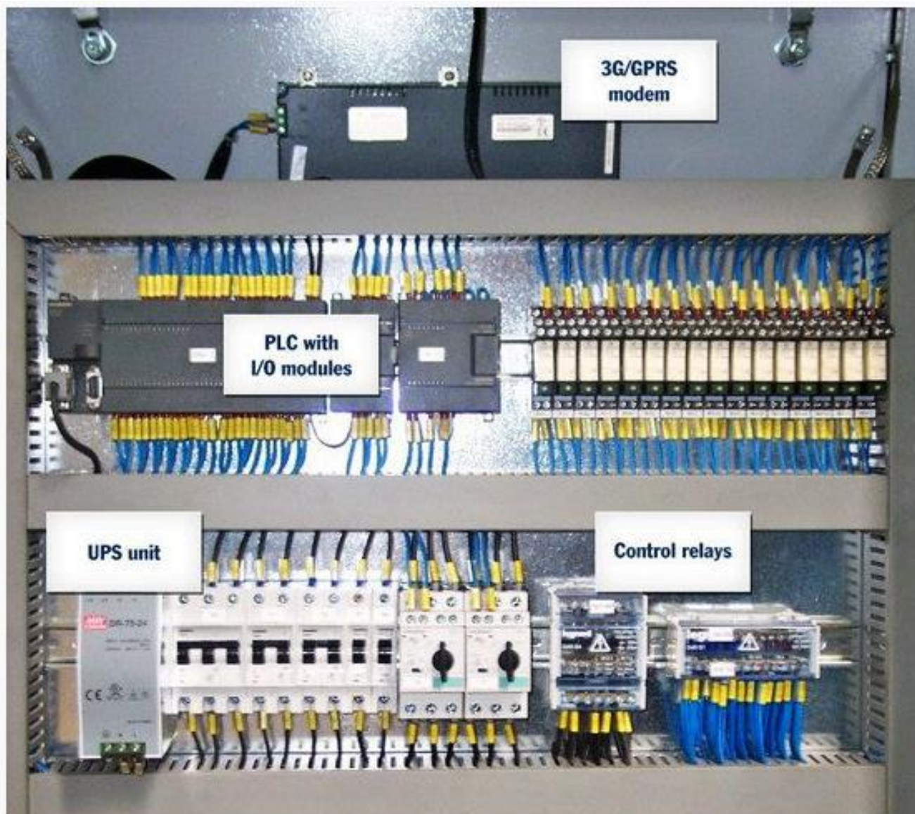
Рисунок А.1 – Шафа управління з проводами та кнопками на передній панелі ПЛК
