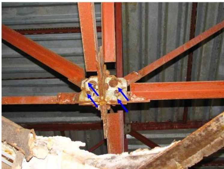
Фото 40. Стик поясів діагональних ферм між собою з допомогою накладок на болтах.
