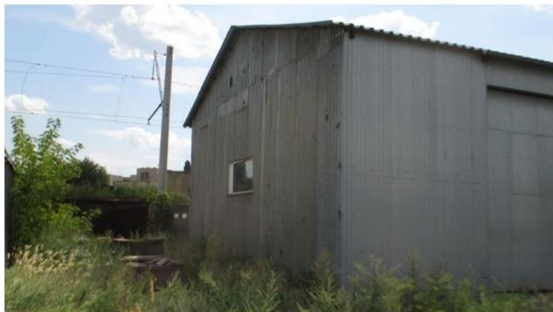
Фото 4. Фасад будівлі в осях А-В.
