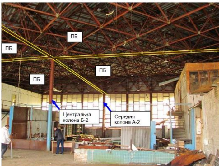
Фото 9. Каркас будівлі ангару. Колона каркасу, на яку опираються 4 просторових блоки (ПБ) розмірами в плані 15х15м з плоских ферм висотою 2121мм.
