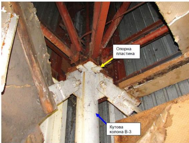
Фото 28. Обпирання просторового блоку на кутову колону В-3.
