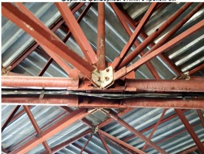
Фото 35. Стик (до нижнього поясу) елементів поясів діагональних ферм до контурної ферми з допомогою накладок на болтах.
