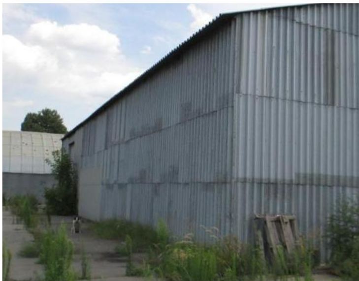
Фото 1. Загальний вигляд фасаду будівлі на перетині осей В-1. Фасад з сендвіч панелей з сталевого оцинкованого профлиста.
