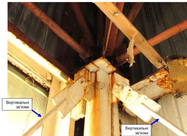
Фото 29. Вертикальні зв'язки з ст.кр.Ø20мм. Розміщуються по чотирьох кутах каркасу будівлі ангару.
