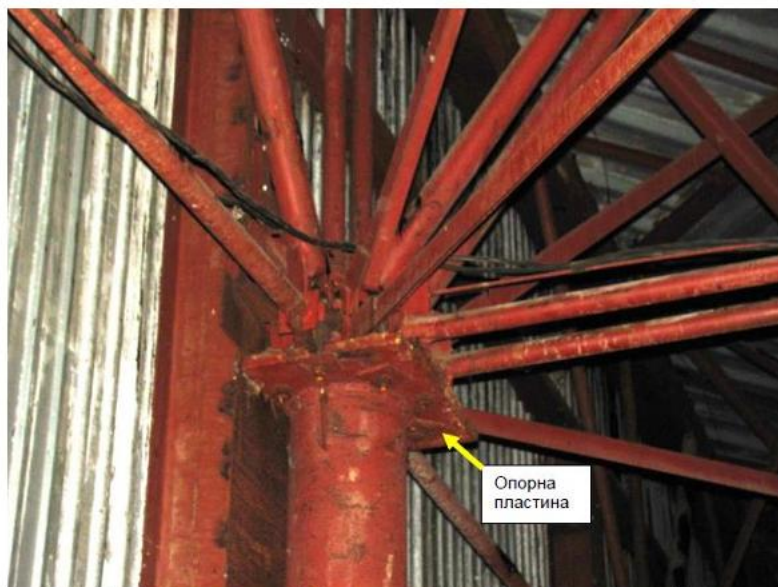
Фото 26. Середня колона Б-3 на яку обпираються два просторові блоки.
