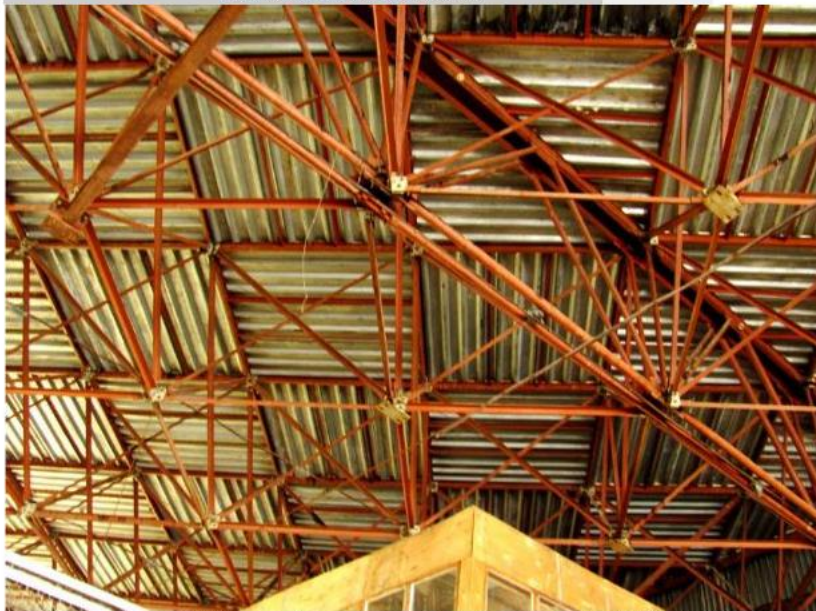
Фото 37. Висота ферм просторового перекриття 2121мм.
