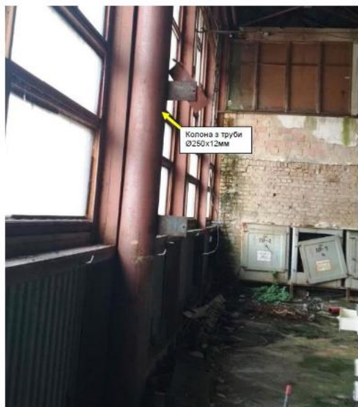
Фото 24. Середня колона В-2 на яку обпираються два просторові блоки.
