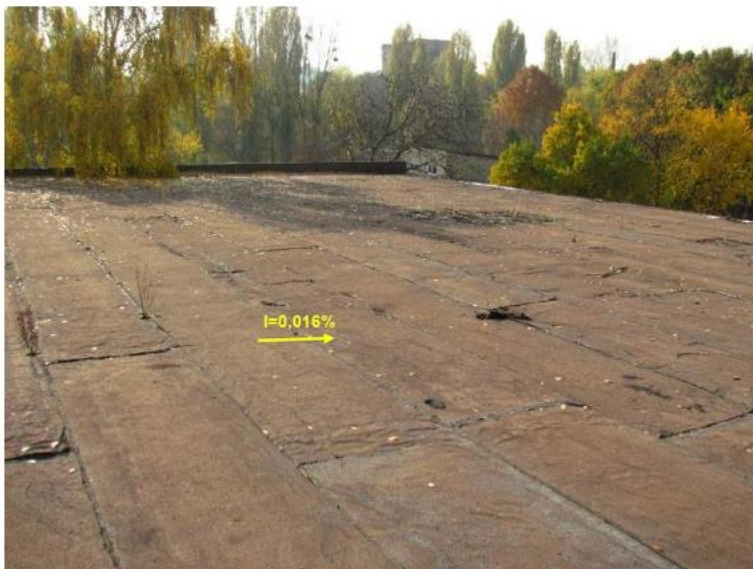
Фото 44. Загальний вид плоского ( i=0,016\% ) даху ангару. Водовідведення неорганізоване.
