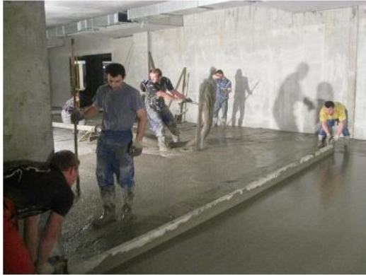
Рис 3.1. Прийом і розрівнювання бетонної суміші.
