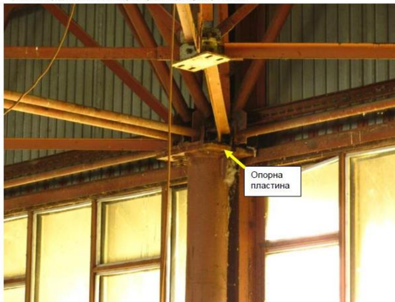
Фото 25. Середня колона А-2 на яку обпираються два просторові блоки.
