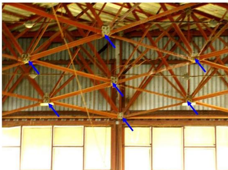
Фото 38. Стик елементів поясів діагональних ферм з допомогою накладок на болтах.
