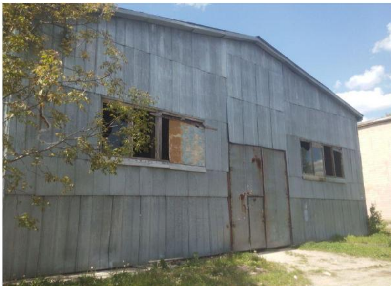
Фото 2. Фасад будівлі в осях В-А. В'їзні ворота в ангар.
