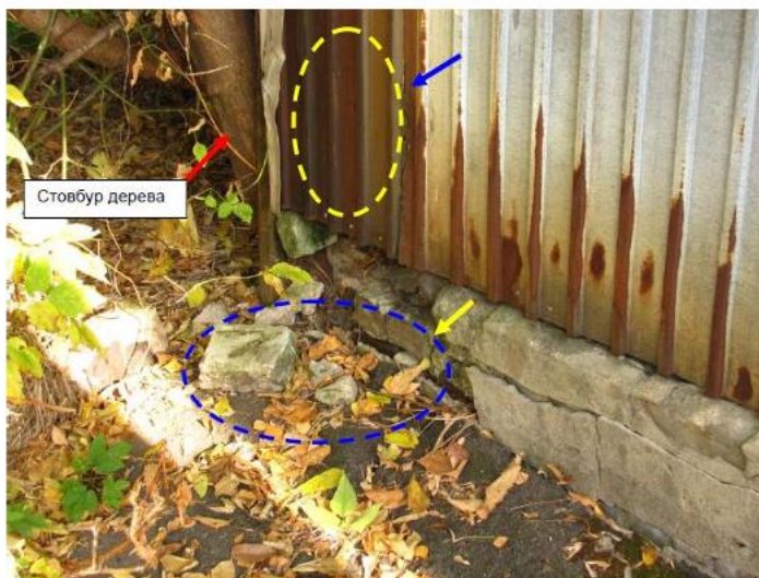
Фото 8. Кут будівлі на перетині осей В-3. Сліди замокання цокола, відшарування тиньку. Поверхнева корозія профлистів. Наявність дерева біля фундаменту кутової колони каркасу будівлі.
