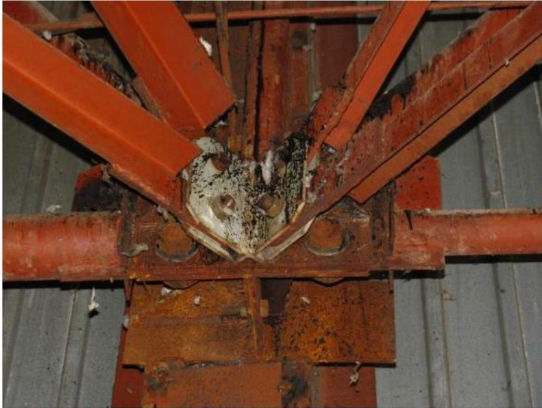
Фото 31. Бокове кріплення до стійки фахверку просторової конструкції перекриття.
