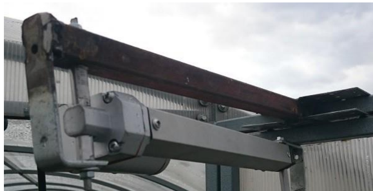
Рисунок 3.3 Загальний вигляд актуатора та монтаж
