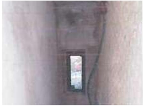
Рис. 6.20. Сліди замокання, висоли
