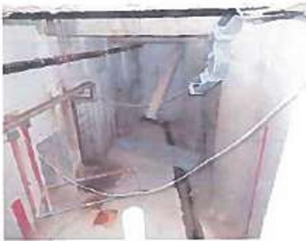
Рис. 6.7. Сліди замокання, руйнування штукатурного шару на ділянках стіни та підлоги Рис. 6.8. Сліди замокання, висоли на ділянках стіни та підлоги
