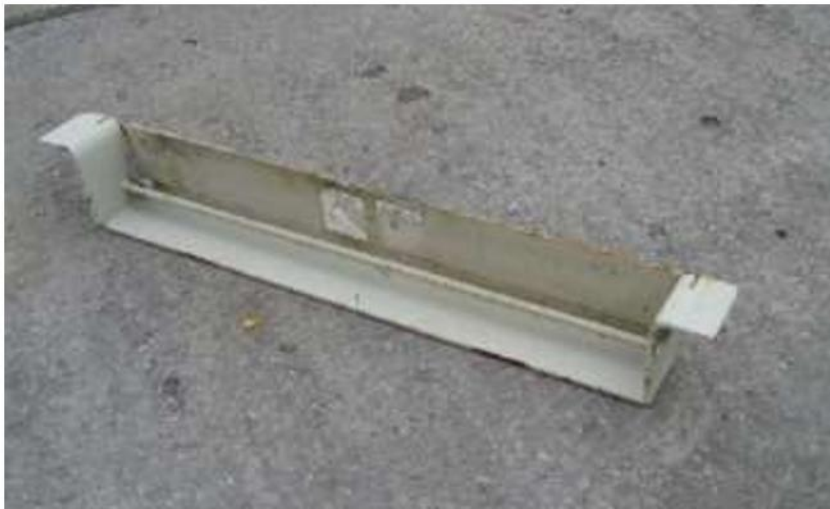
Рис. 3.6. Спеціальний при опорний елемент для плит
