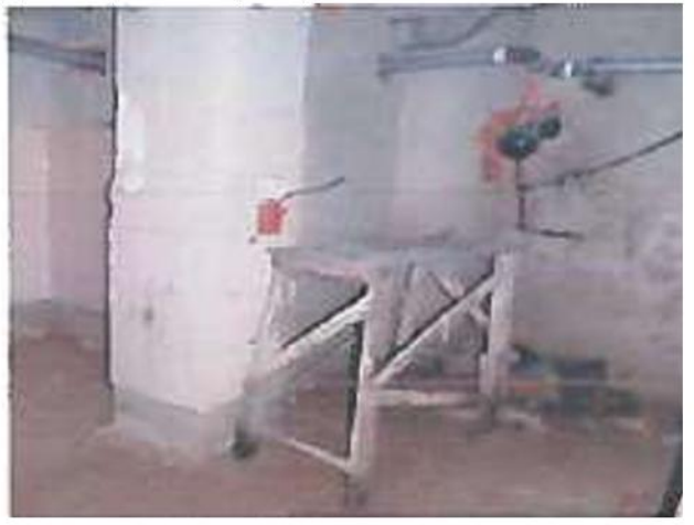
Рис. 6.11. Сліди замокання на ділянках підлоги Рис. 6.12. Руйнування оздоблення на ділянках стіни, сліди замокання
