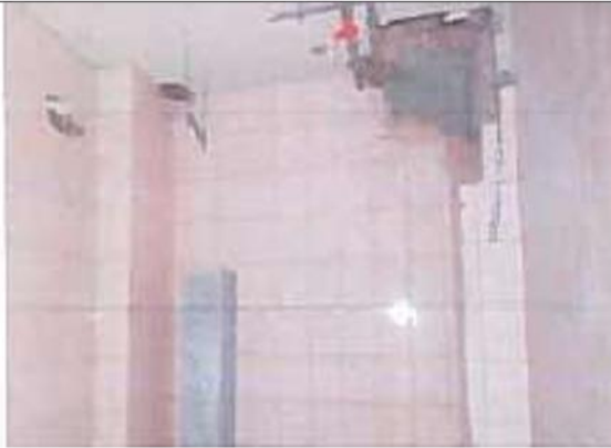
Рис. 6.7. Сліди замокання, руйнування штукатурного шару на ділянках стіни та підлоги Рис. 6.8. Сліди замокання, висоли на ділянках стіни та підлоги
