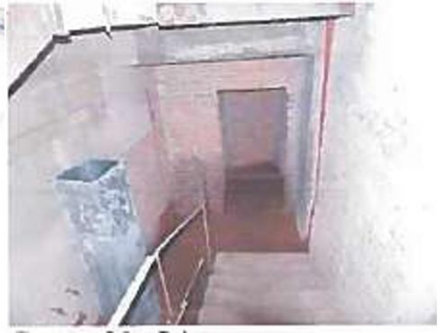
Рис. 6.7. Сліди замокання, руйнування штукатурного шару на ділянках стіни та підлоги Рис. 6.8. Сліди замокання, висоли на ділянках стіни та підлоги
