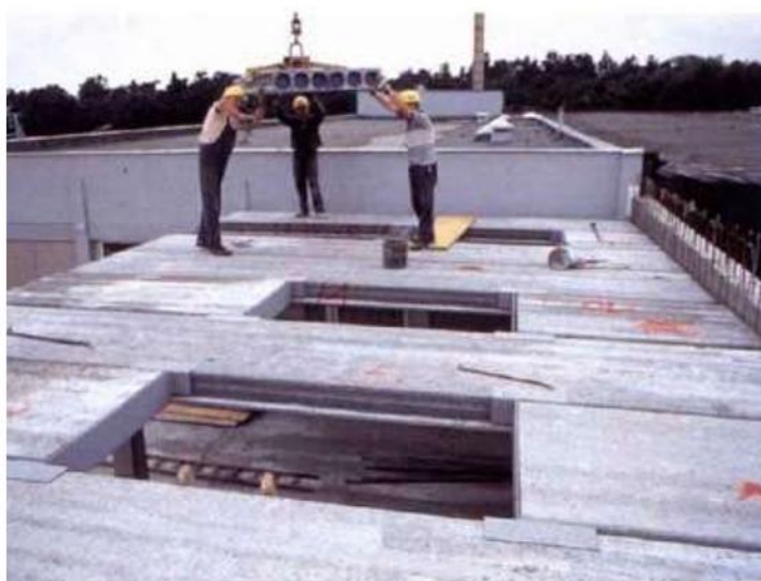
Рис. 3.7. Вигляд при опорного елемента під час монтажу перекриття
