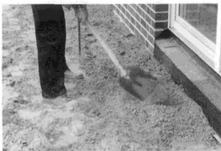
1. Влаштування несучої основи.
