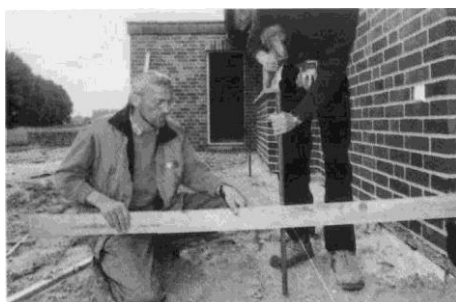
2 - Вимірювання ухилу.
