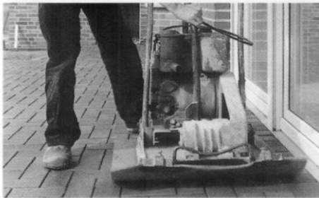
Рис.3.4 Процес вкладання бруківки
