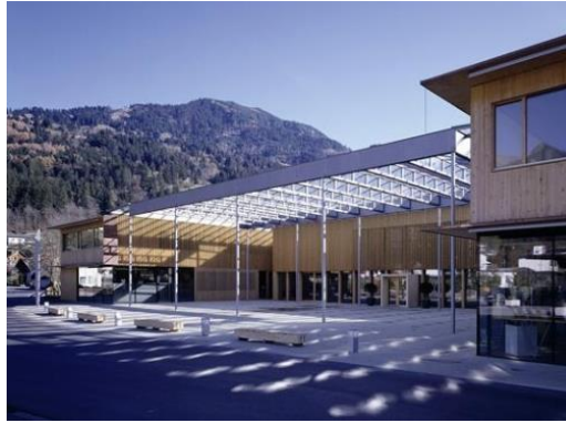
Рис. 19. Зимовий сад громадського центру в Людеші (Австрія) під напівпрозорими фотоелектричними модулями
