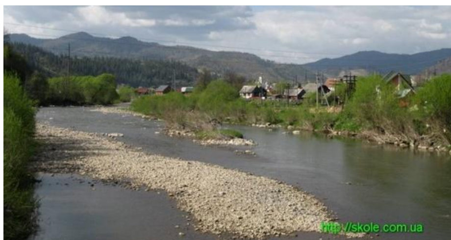
Рис. Г.2. Приватні житлові споруди в заплаві та першій терасі р. Опір у с. Тухля, на ділянці підвищеної небезпеки при проходженні повені та паводку [145]
