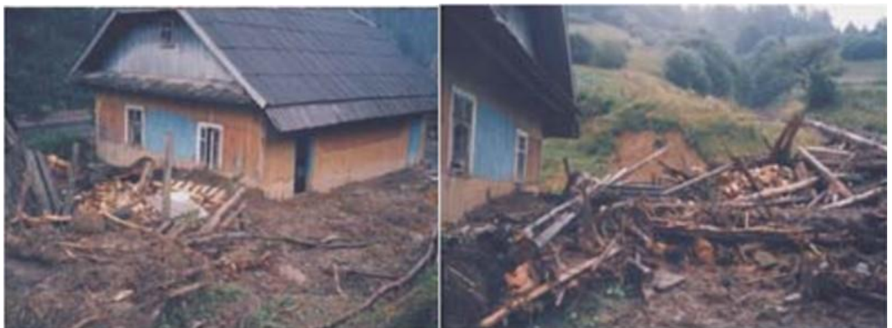
Рис. 1.8. Руйнування житлового будинку, що спричинені сходженням селевого потоку, спричиненого інтенсивними опадами у с. Козева Сколівського р-ну (2004 р.)
