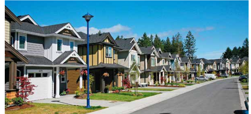
Рис. 3.6. Квартал енергозберігаючих будинків в провінції Бритіш Колумбія, Канада
