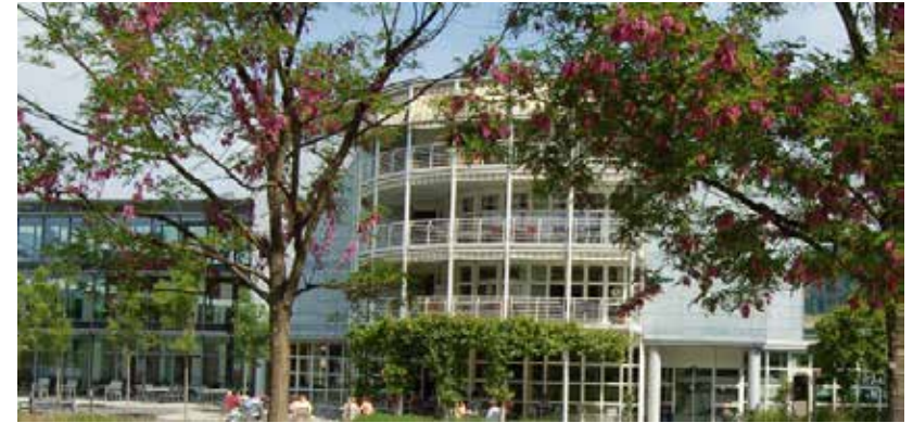
Рис. 1.12. Реконструйований будинок для людей похилого віку в селі Райдені, Швейцарія [Фельдгайм]
